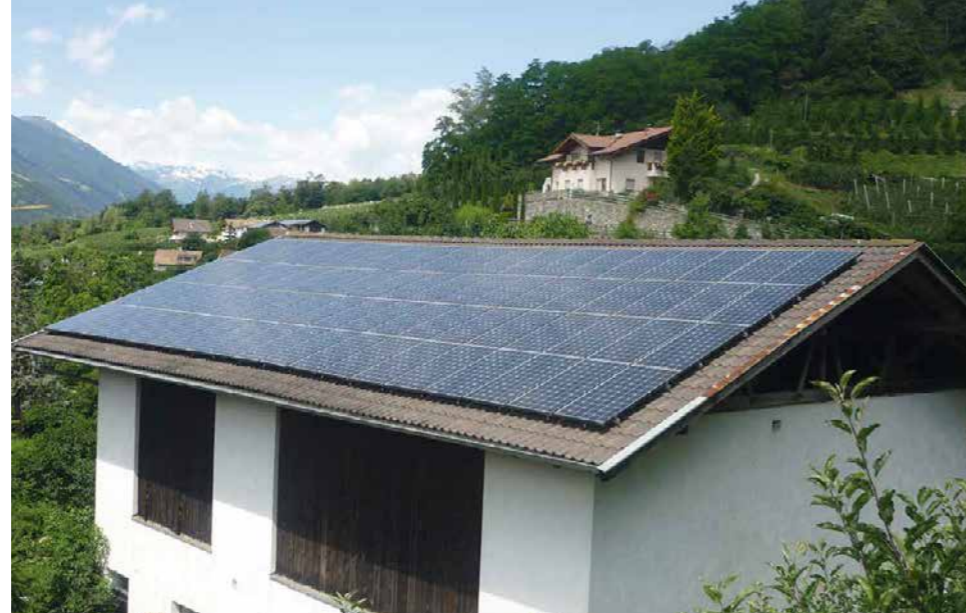
Figura 2 - Tipica installazione su edificio agricolo.
